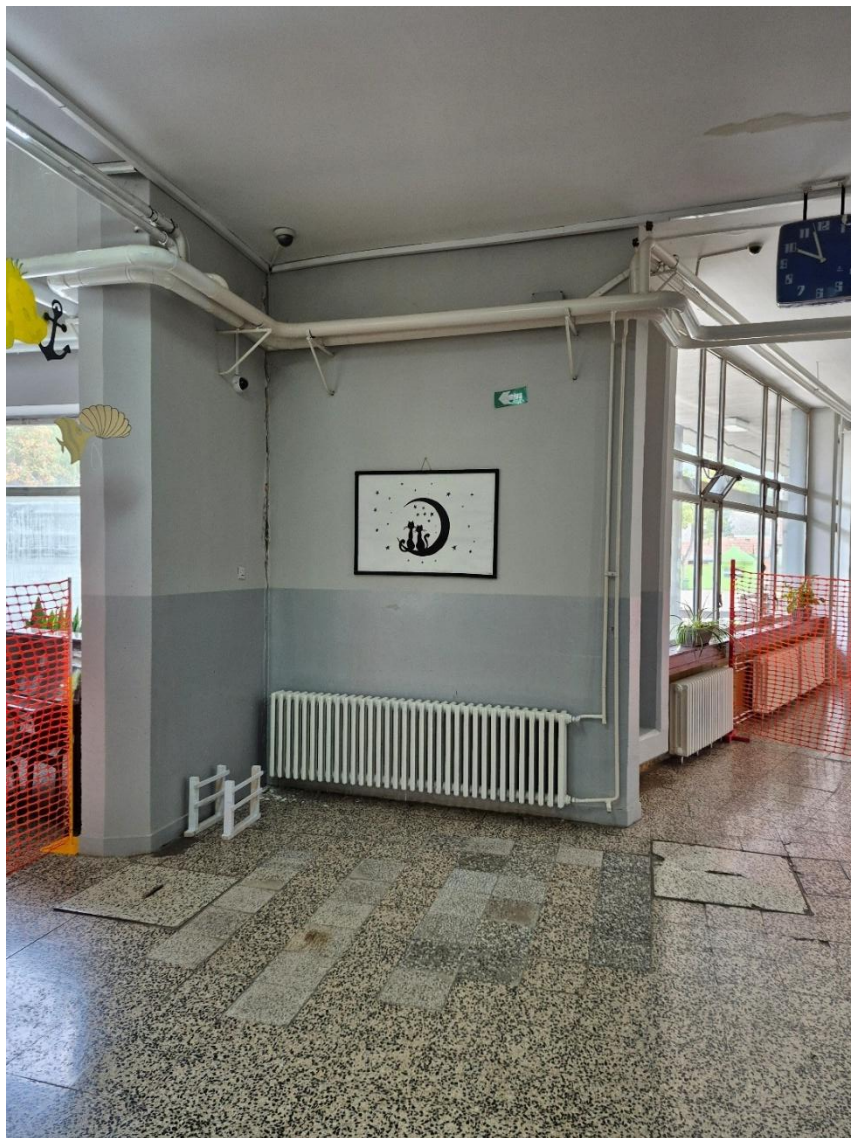
Слика 3.9. Приказ подне плоче у којој је дошло до слегања и шахтова чији је преглед неопходан
