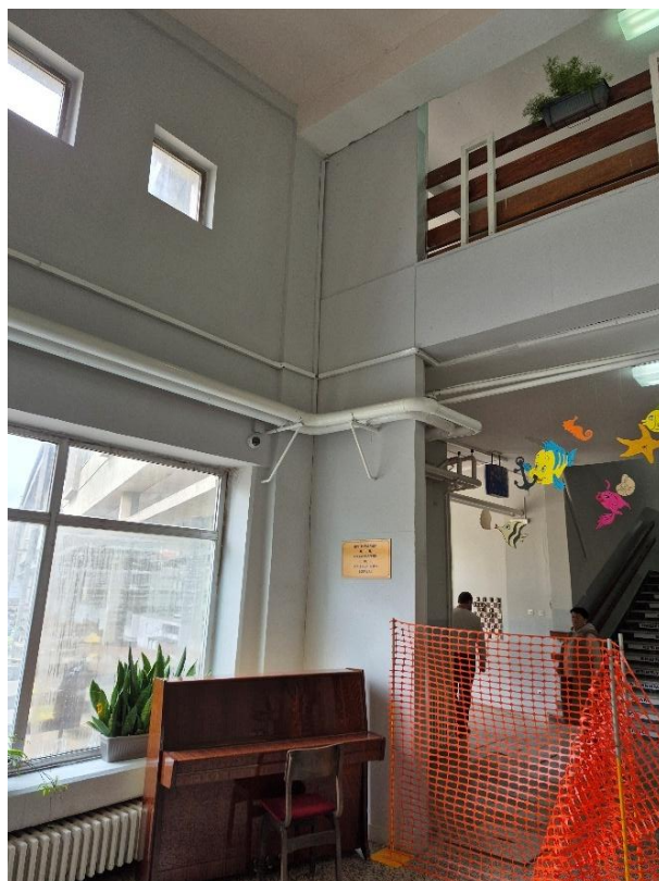
Слика 3.8. Приказ на дилатацији зида у ходнику (са стране улазног хола)
