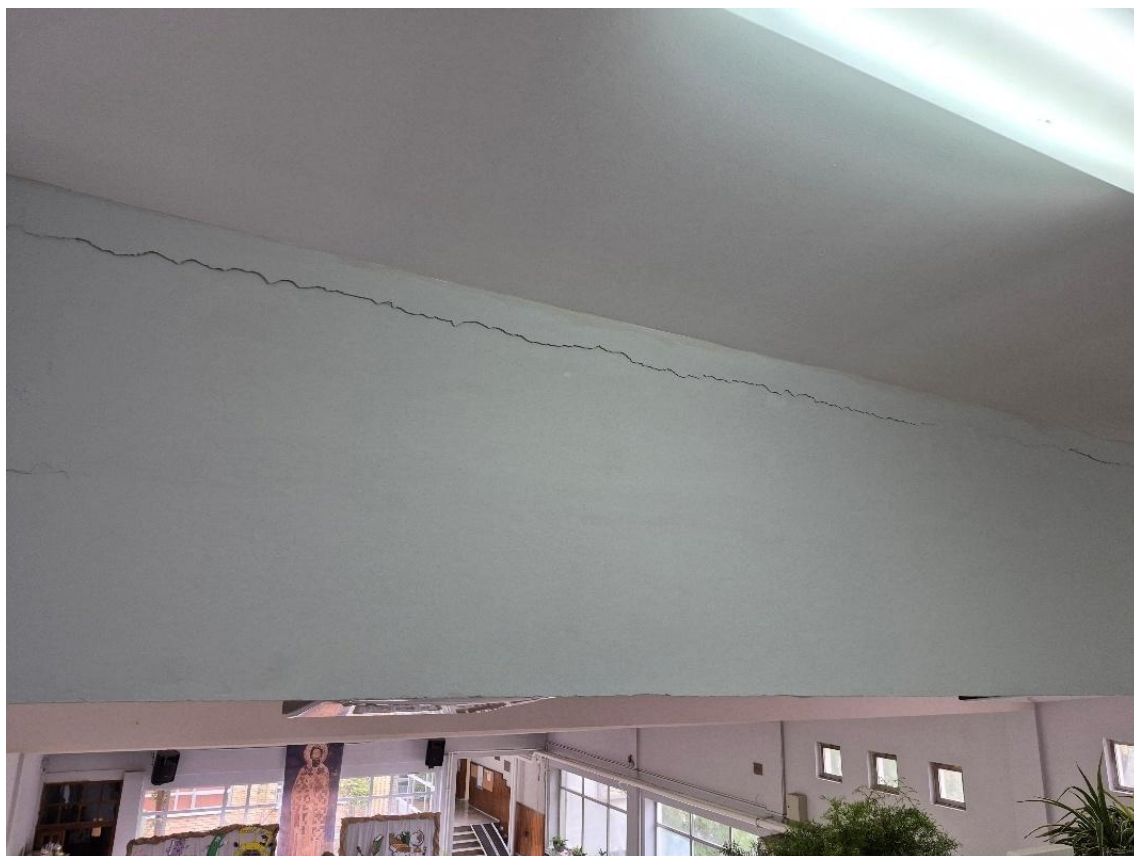
Слика 3.25. Хоризонтално пуцање облоге греде код дилатације по дужини
