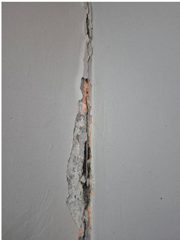
Слика 3.6. Приказ на дилатацији зида у ходнику (након скидања слојева)
