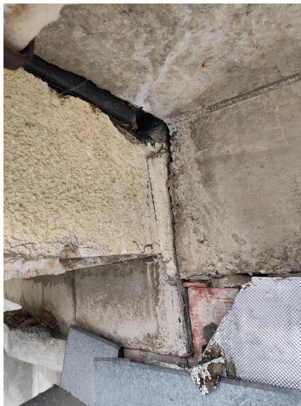
Слика 3.38. Детаљнији приказ зоне дилатације са спољашње стране
