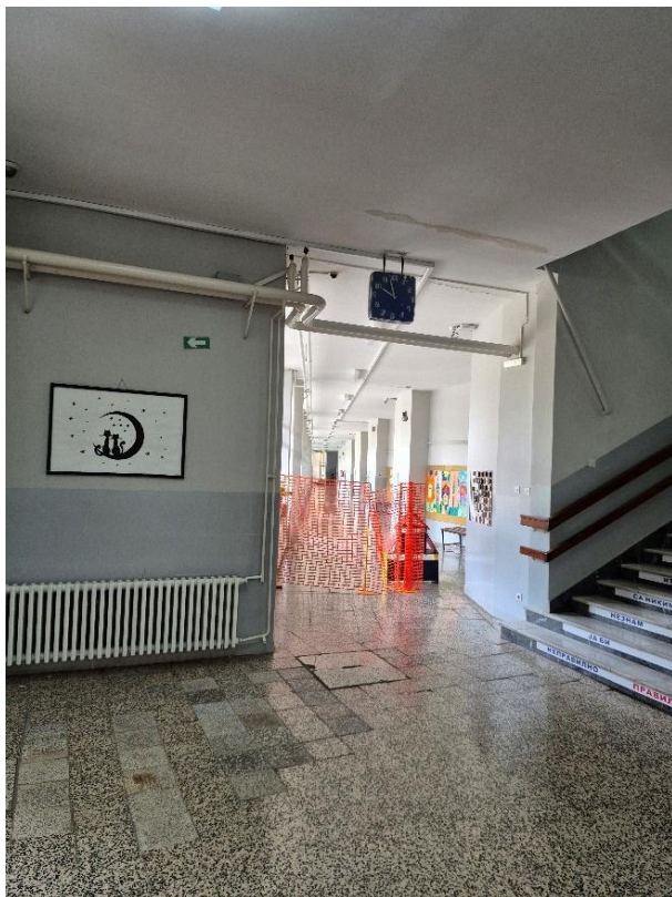
Слика 3.10. Приказ прсLINE у облози (гипс) на плафону приземља (у делу изнад шахта)
