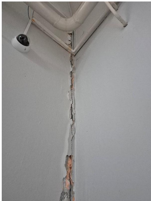
Слика 3.7. Приказ на дилатацији зида у ходнику (при врху)
