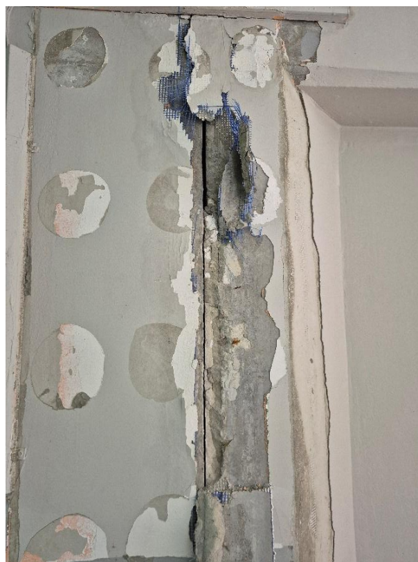
Слика 3.36. Приказ оштећења стуба на који се ослања греда
