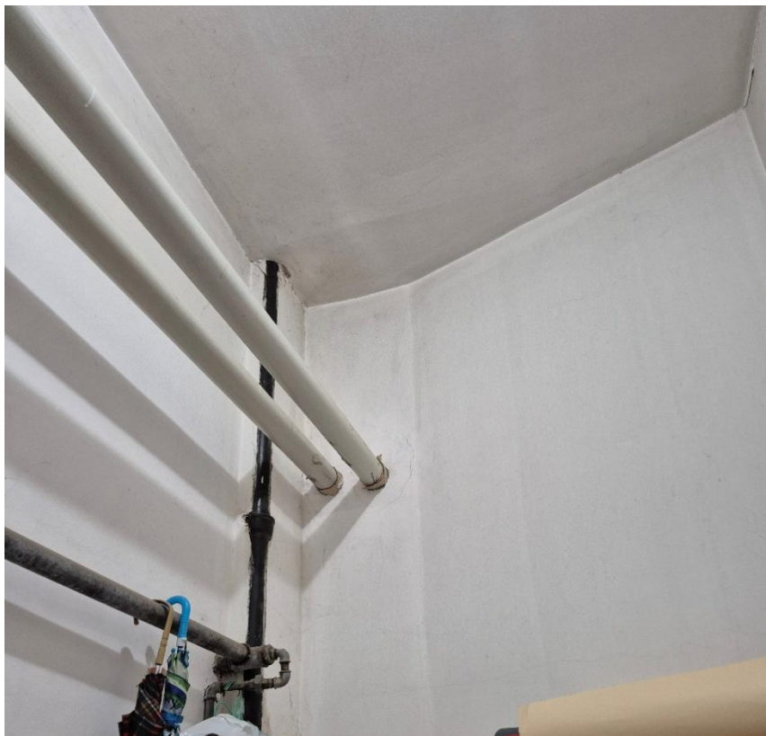
Слика 3.3. Приказ цеви са стране учионица које пролазе кроз зид од опеке уз степениште
