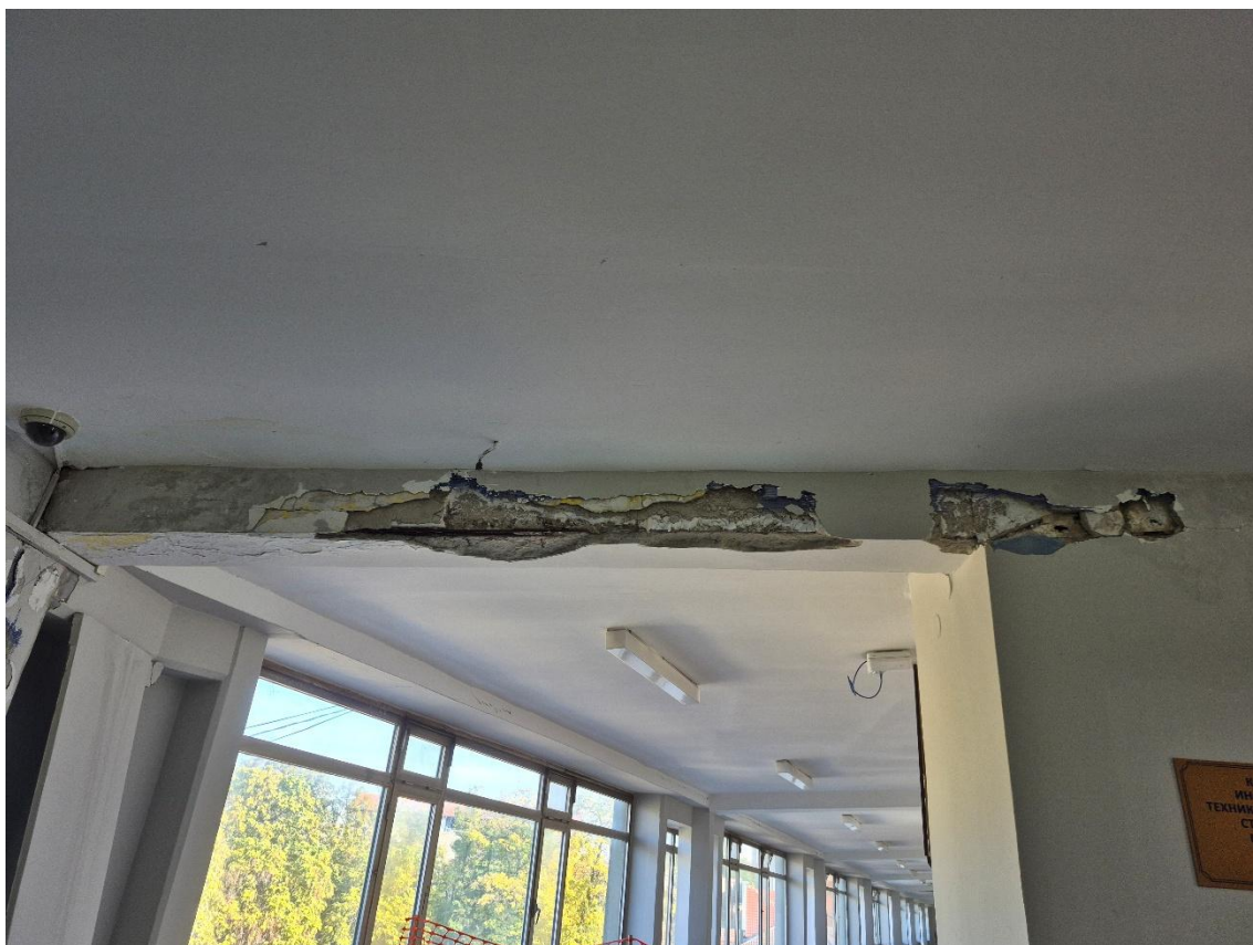
Слика 3.28. Приказ греде након уклањања дела облоге
