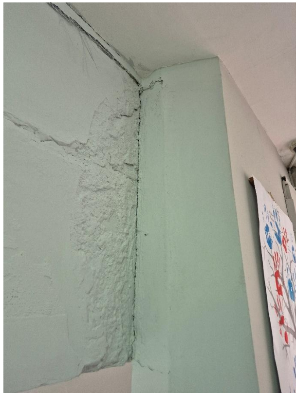
Слика 3.23. Пуцање облоге греде код дилатације са десне стране
