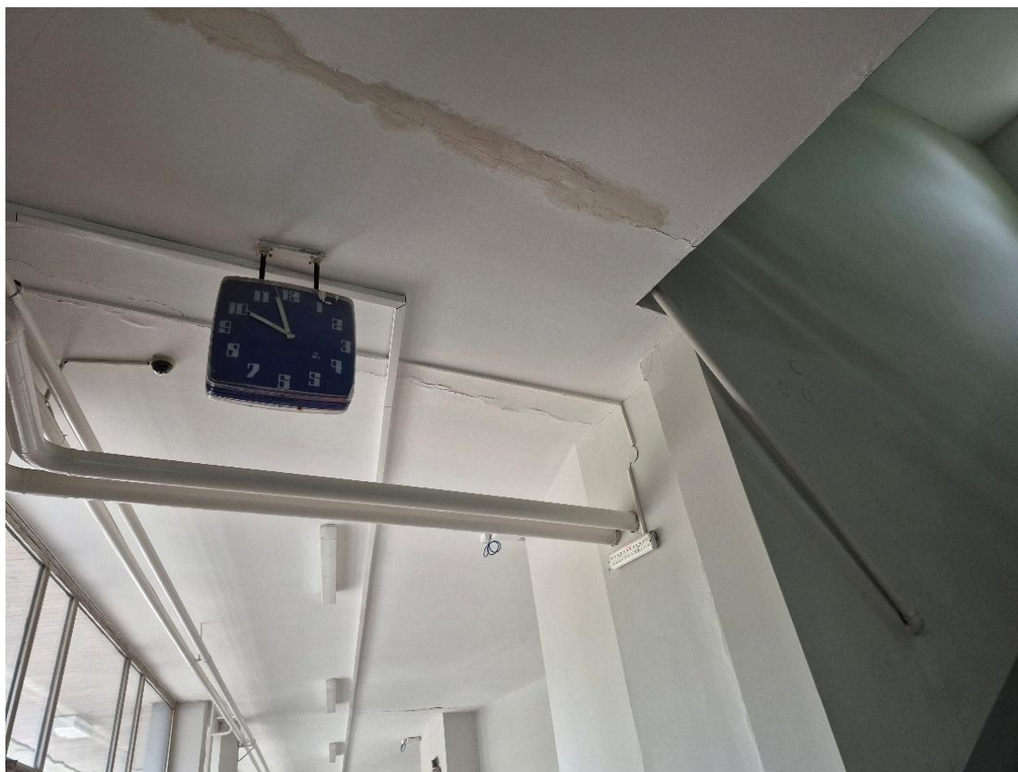
Слика 3.12. Приказ две прсLINE у облози (гипс) спратне плоче
