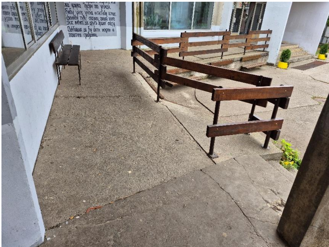
Слика 3.19. Приказ диференцијалног слегања плоча терасе
