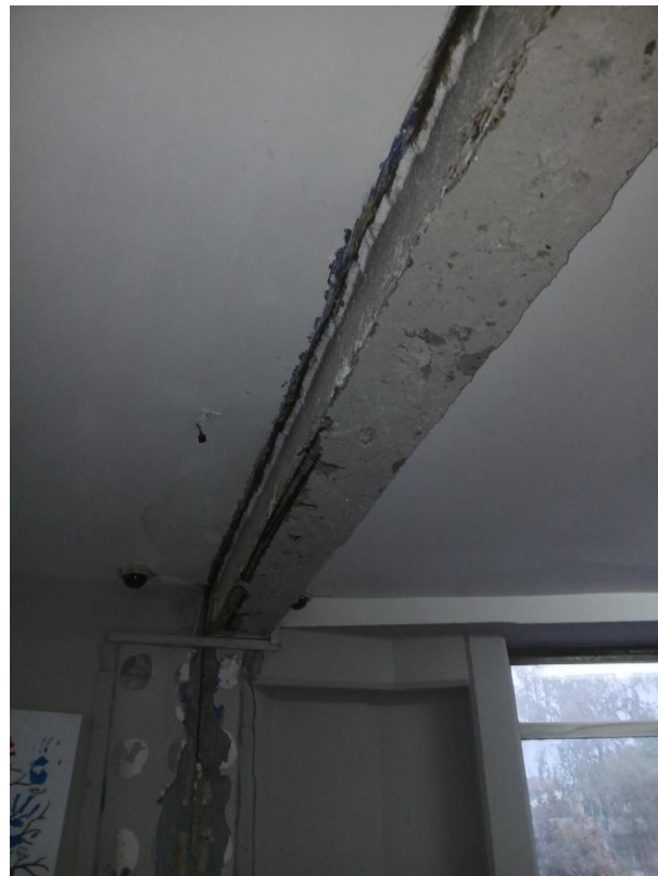
Слика 3.33. Приказ доње стране греде након скидања облоге
