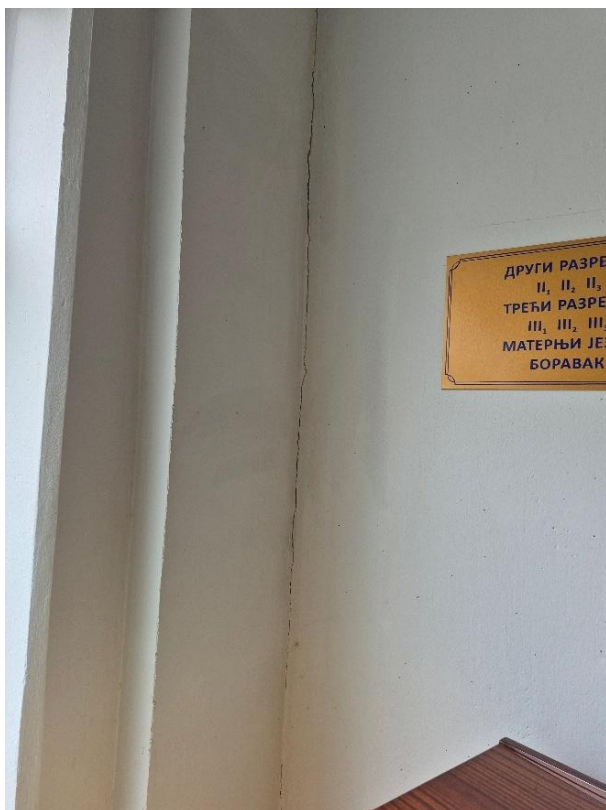
Слика 3.8. Приказ на дилатацији зида у ходнику (са стране улазног хола)
