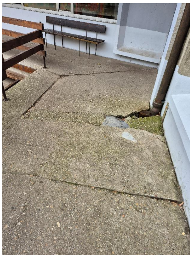
Слика 3.18. Приказ диференцијалног слегања и пуцања плоче терасе на месту везе олука са плочом
