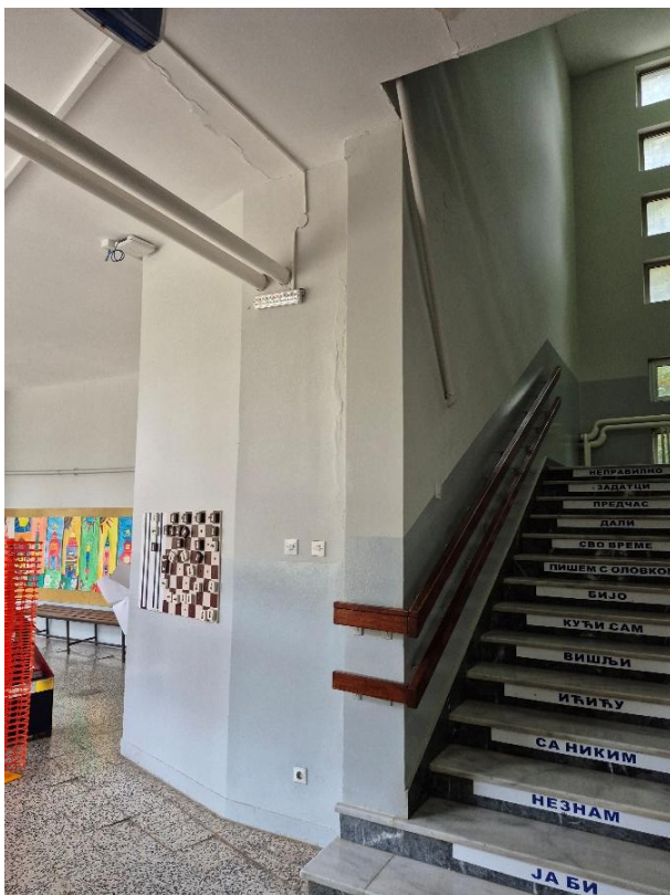
Слика 3.1. Верикална прслина у зиду од опеке уз степениште и пуцање малтера на плафону
