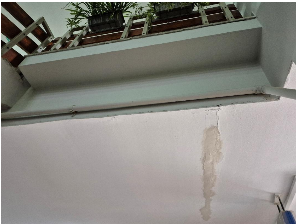
Слика 3.14. Приказ прслина у облози (гипс) спратне плоче са јасно видљивим одвајањем гипс плоча
