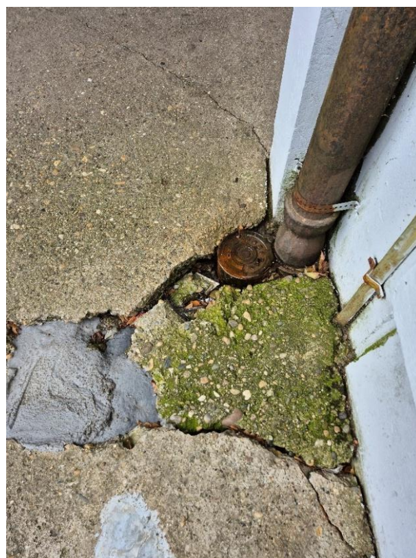
Слика 3.18. Приказ диференцијалног слегања и пуцања плоче терасе на месту везе олука са плочом
