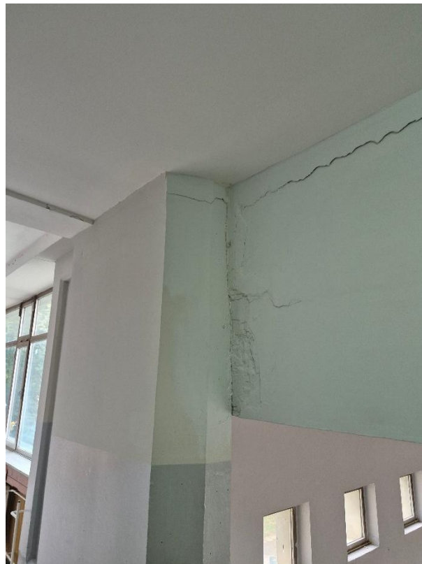
Слика 3.24. Пуцање облоге греде код дилатације са леве стране
