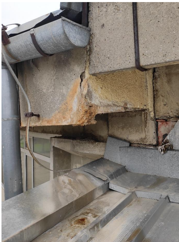
Слика 3.37. Приказ зоне дилатације са спољашње стране
