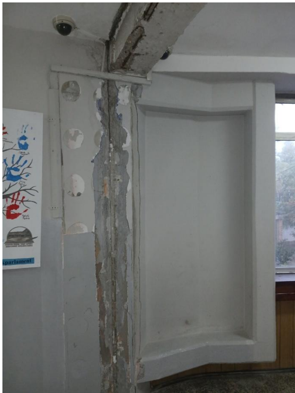
Слика 3.32. Приказ зоне дилатације након скидања облоге
